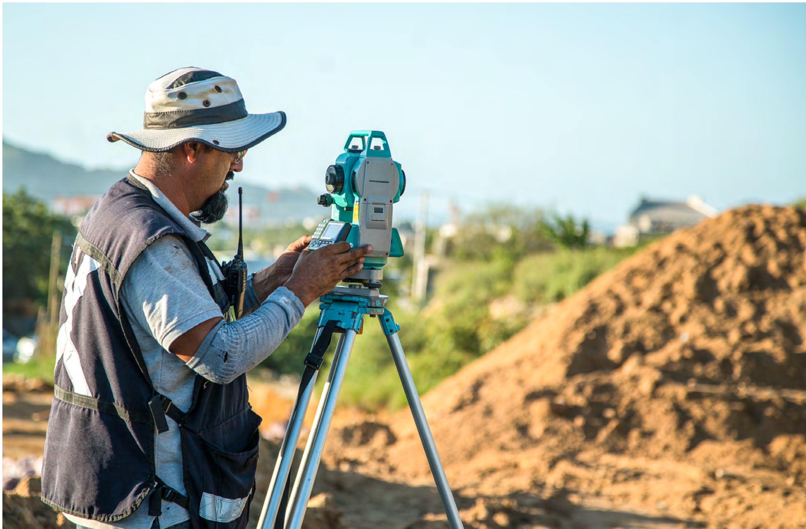
LOS CABOS - TRABAJADOR
