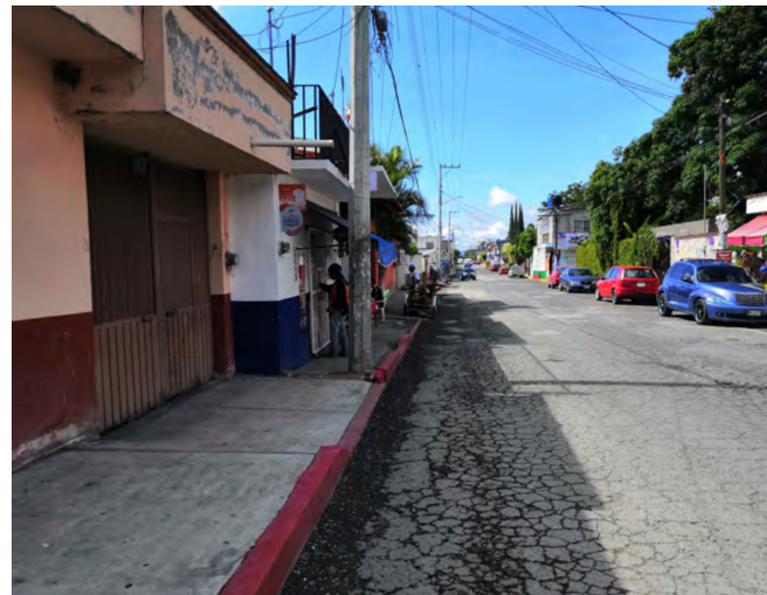
AYALA - CALLES Y AVENIDAS DURANTE REHABILITACIÓN Y MEJORAMIENTO
