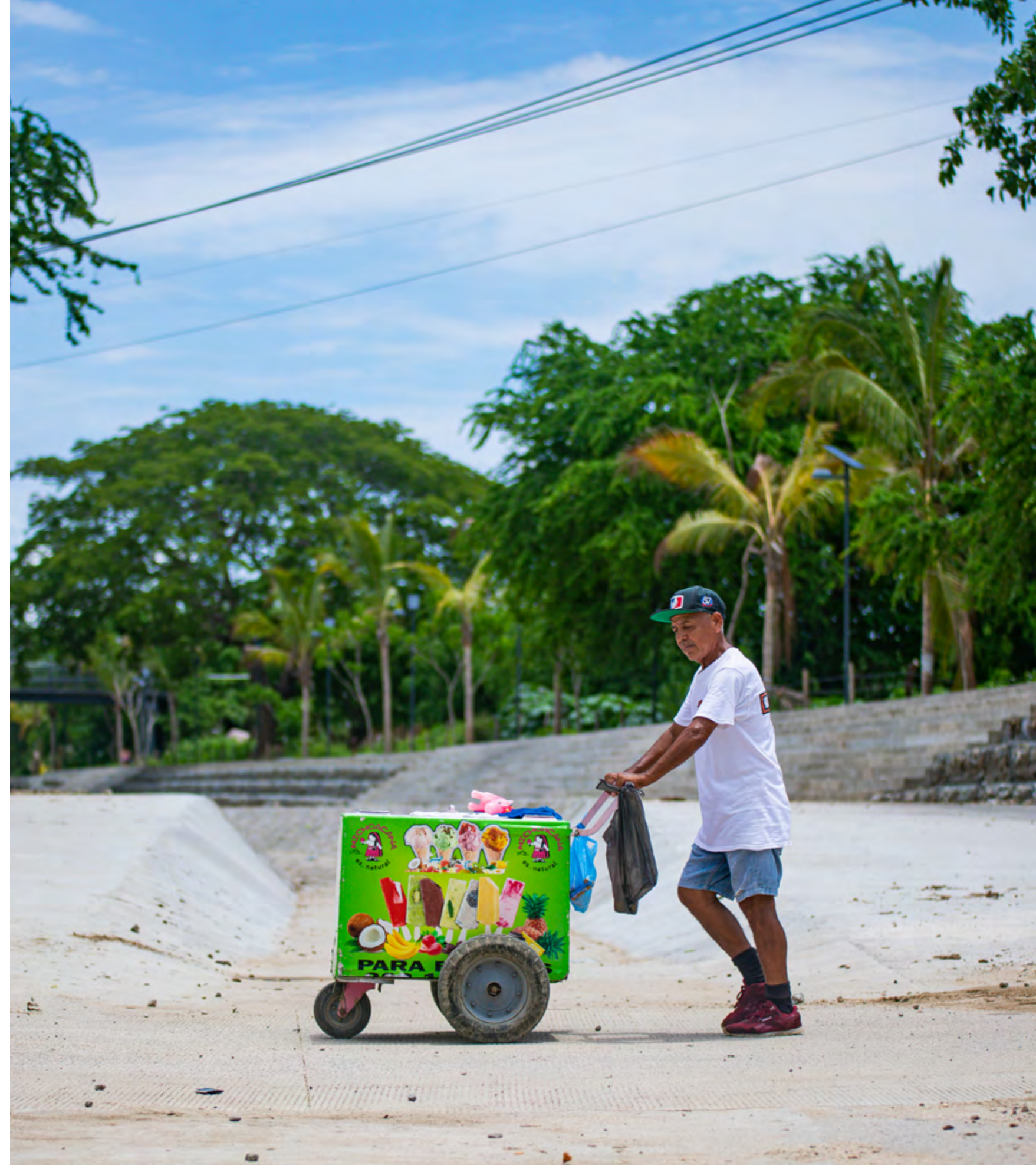
BAHÍA DE BANDERAS - CONSTRUCCIÓN DE MALECÓN
