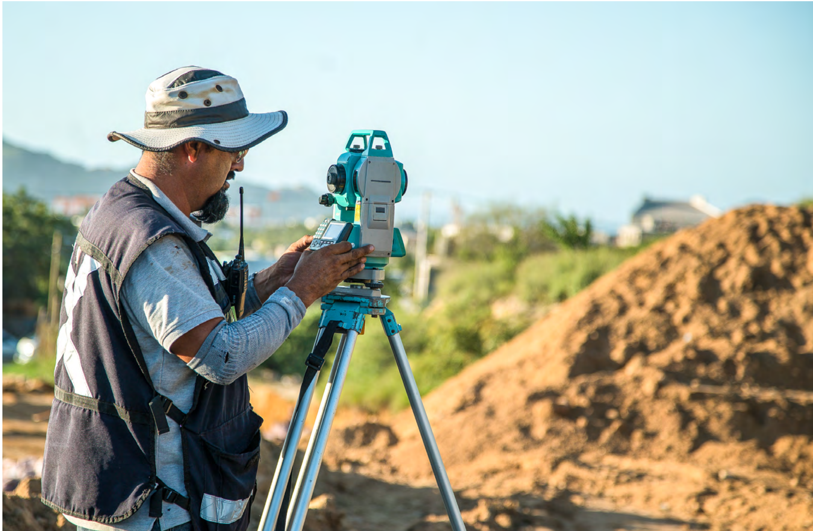
LOS CABOS - TRABAJADOR
