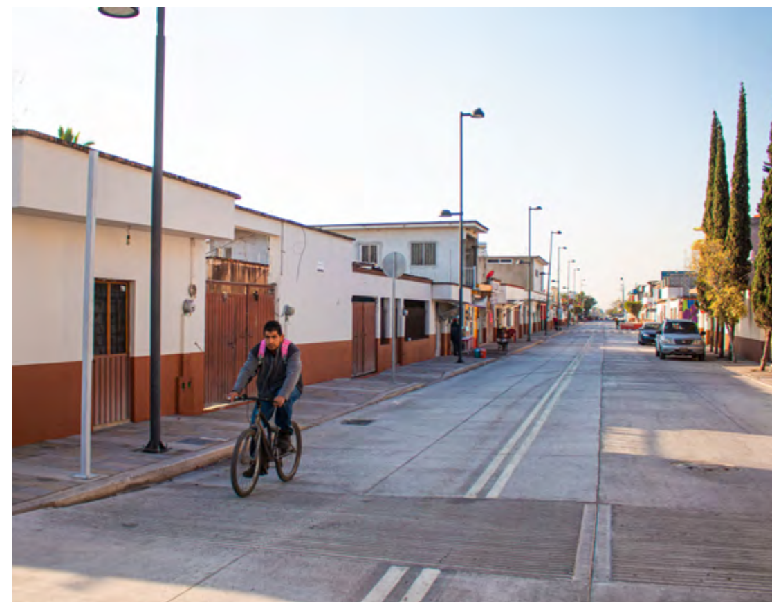
AYALA - CALLES Y AVENIDAS DESPUÉS DE REHABILITACIÓN Y MEJORAMIENTO
